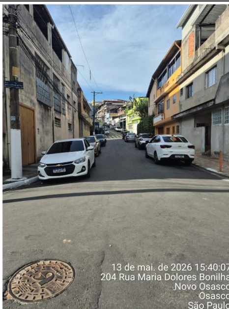
Imagem 04 – Arruamento com guias, asfalto e tampa de acesso a rede subterrânea SABESP
