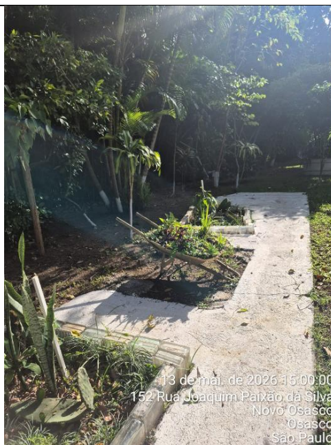
Imagem 33 – Cimentado piso, em parte da Área verde proposta para Recuperação Ambiental (área de 3.016,74m 2 ) para acesso ao jardim criado.
